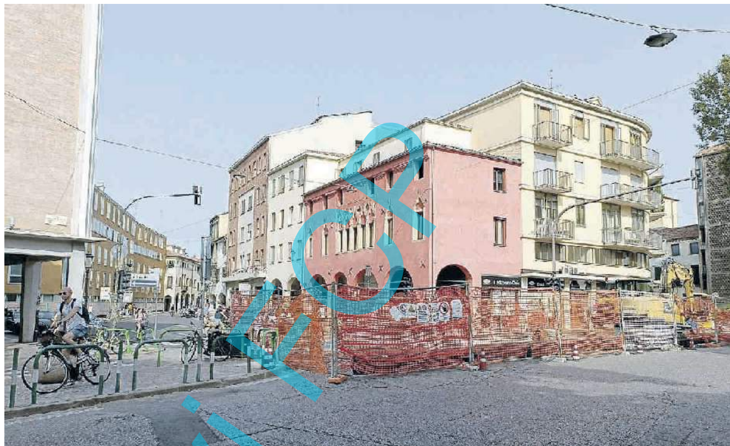
L'ULTIMO CANTIERE Ieri mattina via Belzoni chiusa all'altezza dell'incrocio con via Morgagni e via Falloppio per spostare i tubi del gas metano
